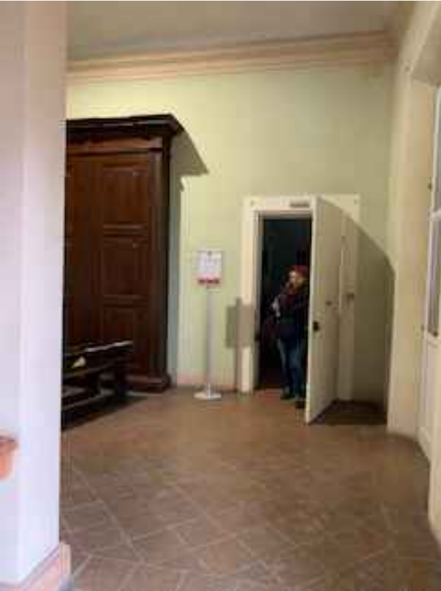
FOTO STATO DI FATTO. serramento leggero provvisorio stagionale per taglio termico
