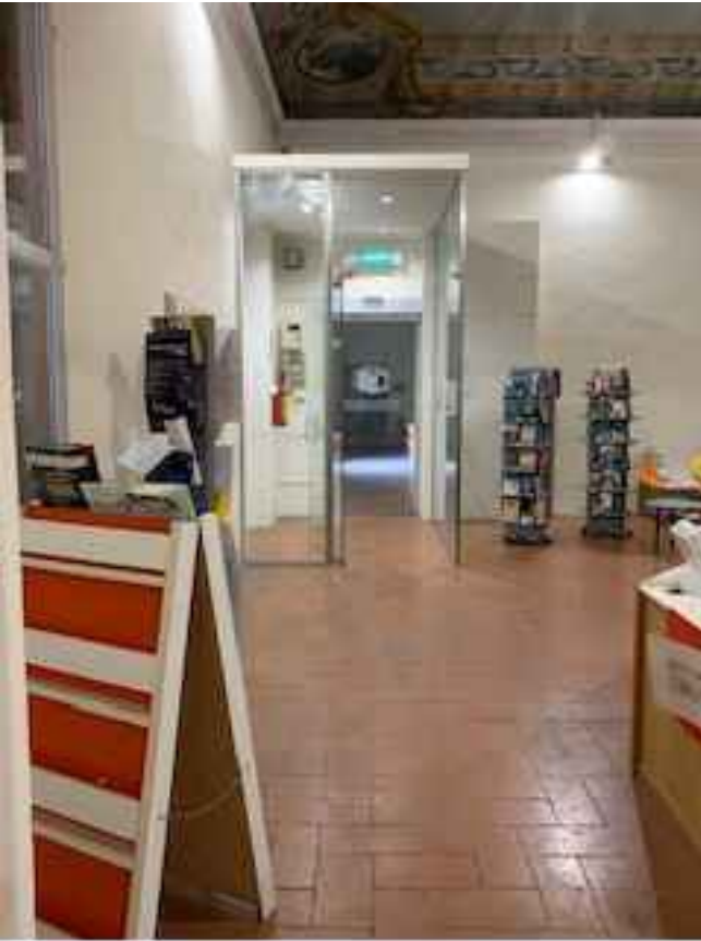
FOTO STATO DI FATTO. serramento leggero provvisorio stagionale per taglio termico
